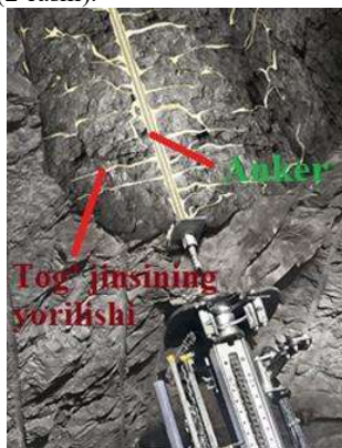
2-rasm. Tog' jinslarini polimer smolalar yordamida mustahkamlashi.
