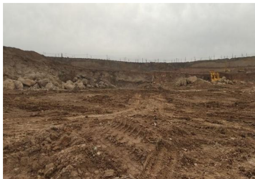
Рис. 2. Общий вид места производства взрывных работ
