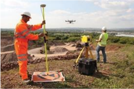
Рис. 1. Приборы (Электронные тахеометры, БПЛА (аэрофотосъёмка) GNSS-наблюдения)
